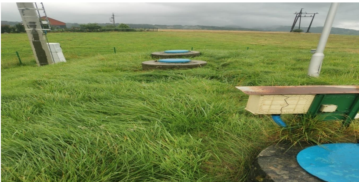
Zdjęcie2. Zdjęcie istniejącego zbiornika wody Kunów (widok na włązy komór zbiorników PE)
