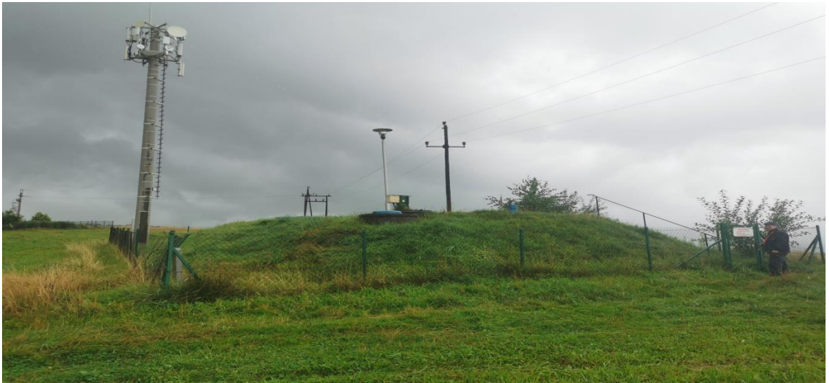
Zdjęcie1. Zdjęcie istniejącego zbiornika wody Kunów (widok na maszt)
